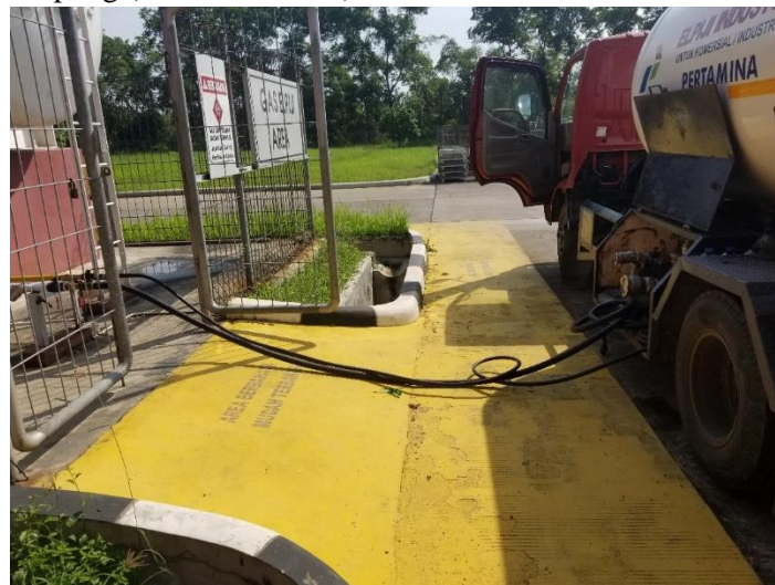
Gambar 7 Kegiatan Pengisian LPG ke Tangki Penampungan
